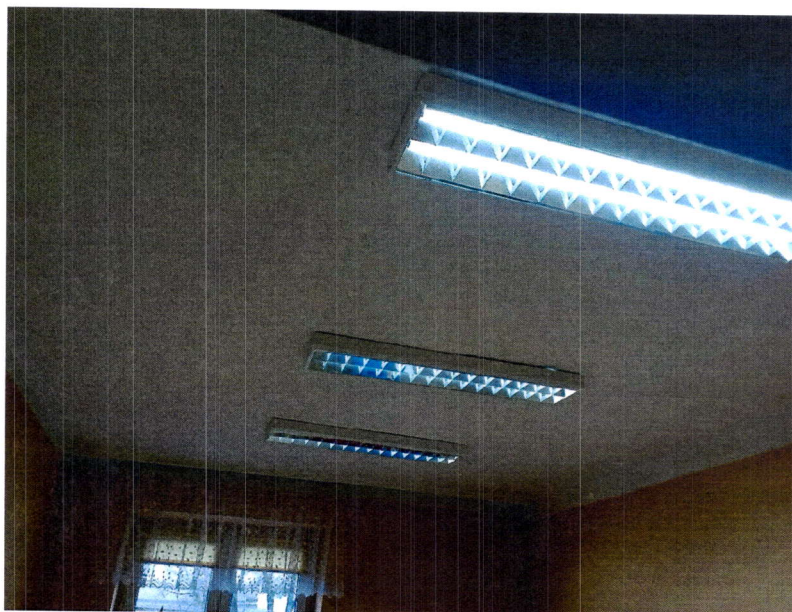
Fot15. Widok sufitu w pomieszczeniu nr115
