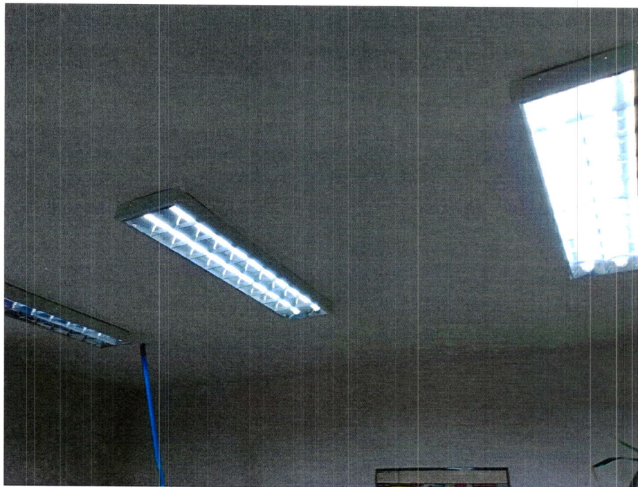
Fot5. Widok sufitu w pomieszczeniu nr5
