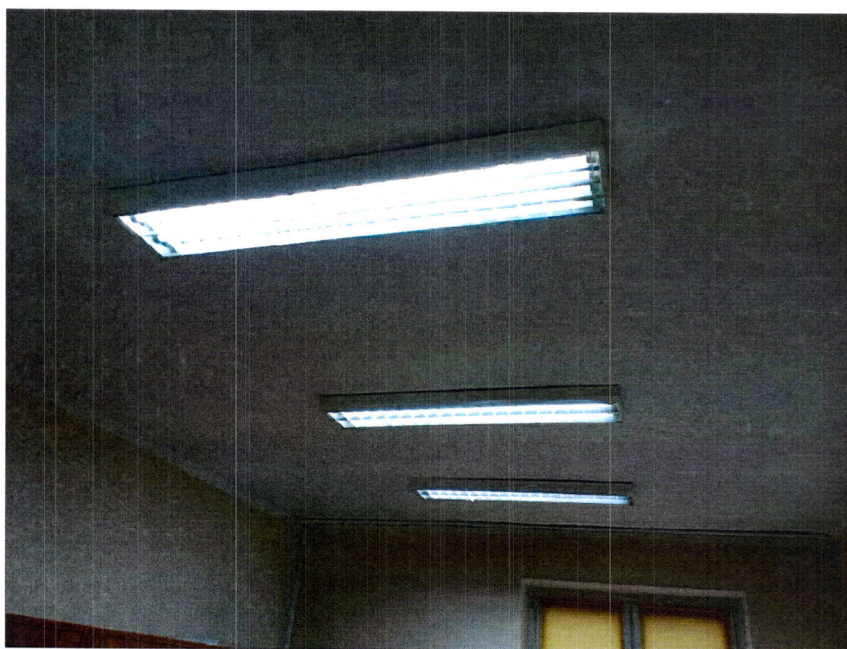
Fot7. Widok sufitu w pomieszczeniu nr102
