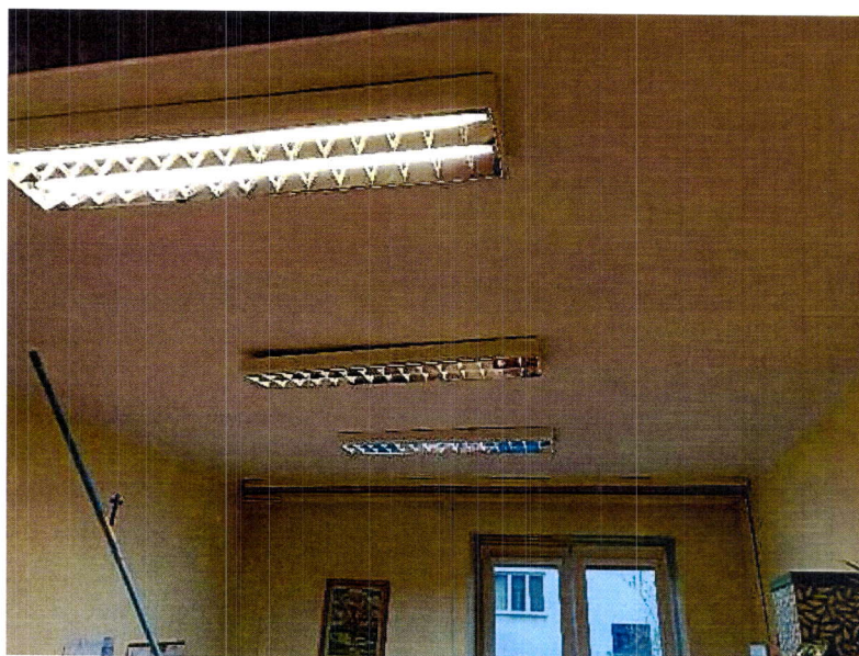
Fot14. Widok sufitu w pomieszczeniu nr110
