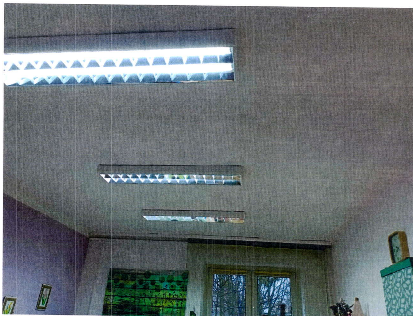
Fot20. Widok sufitu w pomieszczeniu nr121
