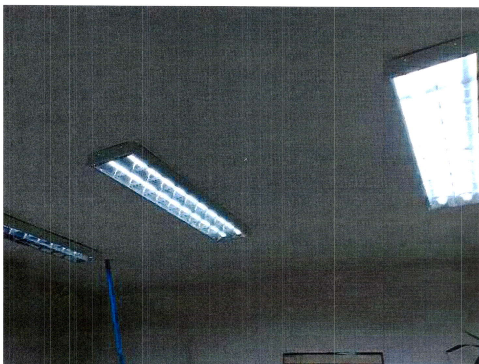
Fot4. Widok sufitu w pomieszczeniu nr4
