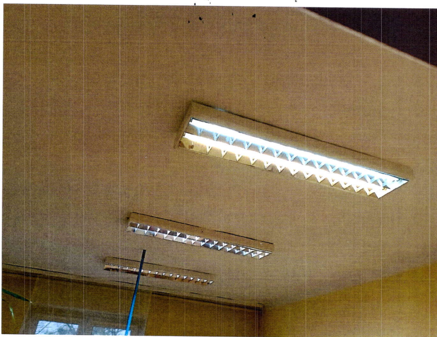
Fot19. Widok sufitu w pomieszczeniu nr119
