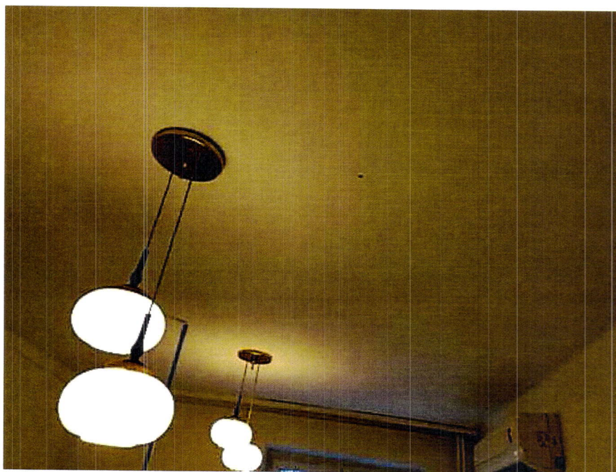
Fot18. Widok sufitu w pomieszczeniu nr118
