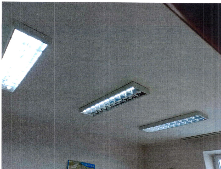
Fot3. Widok sufitu w pomieszczeniu nr2
