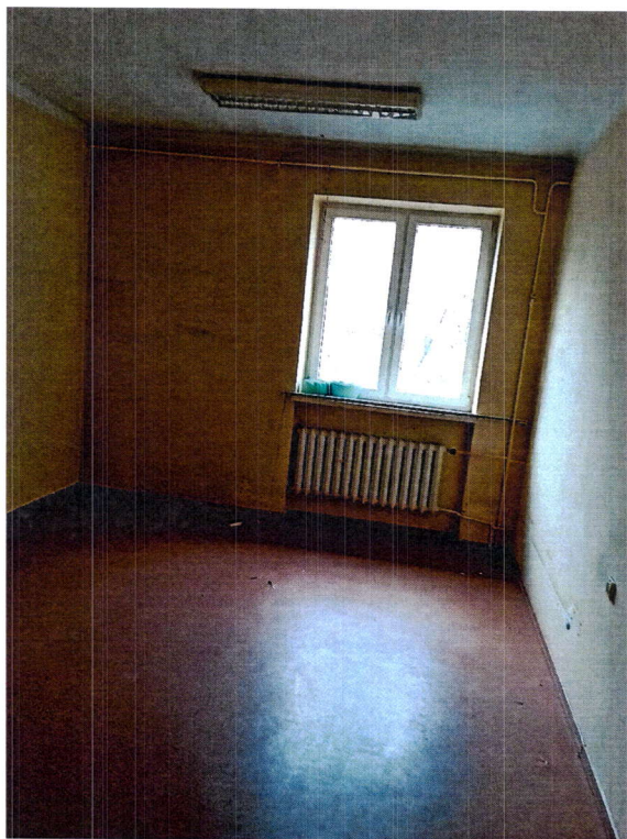
Fot21. Widok sufitu w pomieszczeniu nr123
