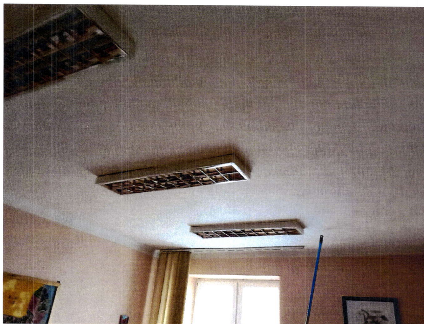
Fot6. Widok sufitu w pomieszczeniu nr7
