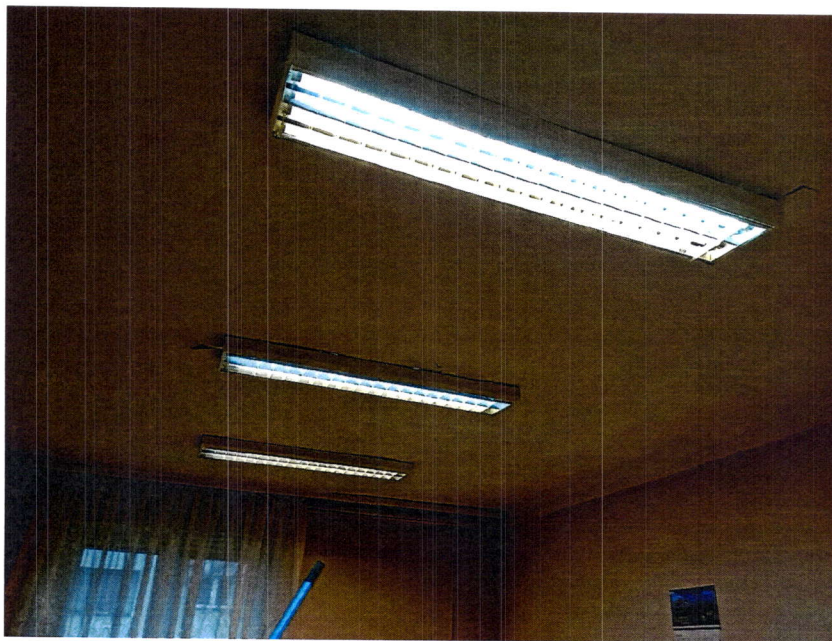
Fot11. Widok sufitu w pomieszczeniu nr107
