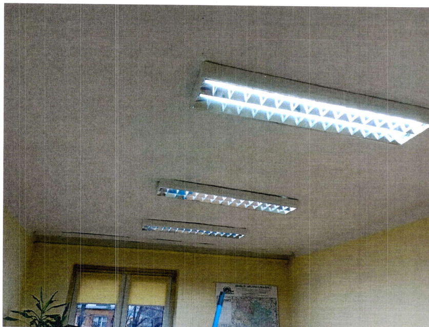
Fot17. Widok sufitu w pomieszczeniu nr117
